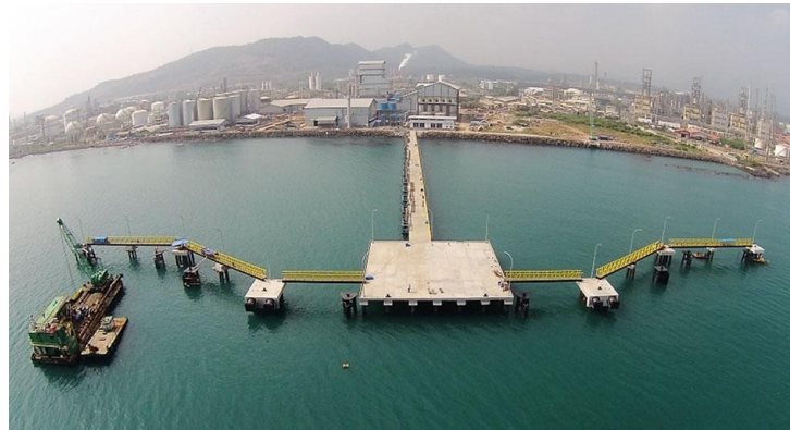
Marine pile foundation (Jetty)
